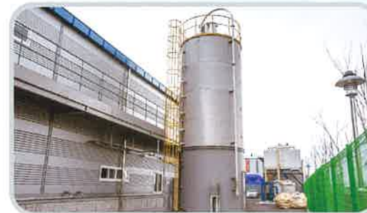
사일로 원재료 입고 (중량에 의한 자동 재고관리 시스템)
